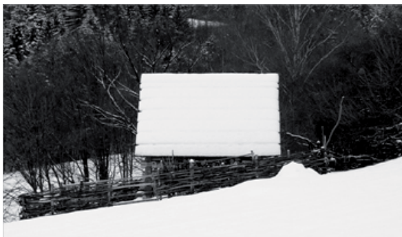
Stávající stav - koliba „srub“
