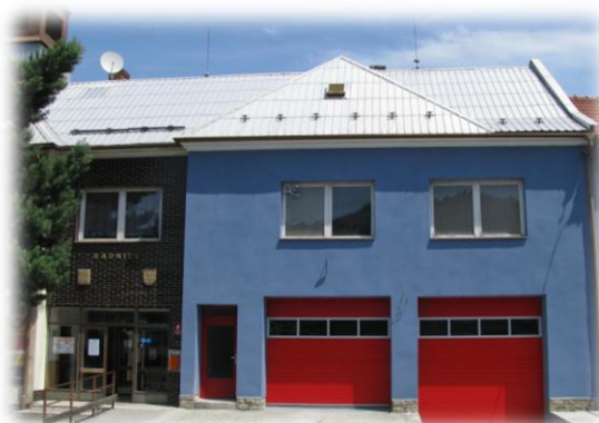
Obr.č.2.: Pohled po rekonstrukci
