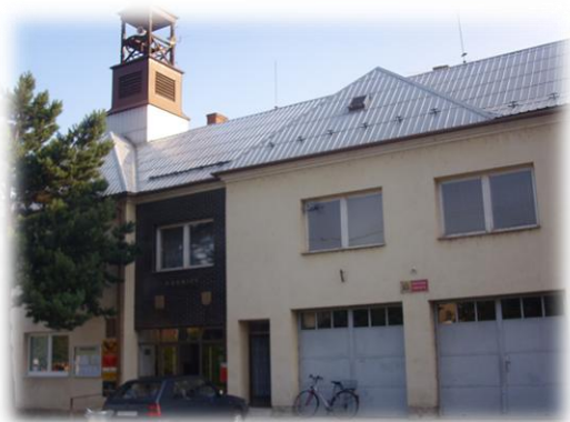
Obr. č.1.: Pohled na hasičskou zbrojnici před rekonstrukcí
